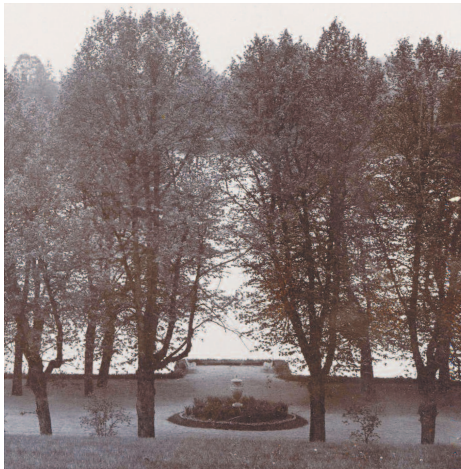
Spaserterrassen i midtaksen foran huset. Her stod et lysthus som trolig ble revet i 1870-årene. Fundament for huset er blitt en pir ut i vannet, med gress og torvkanter. Bildet er fra 1880-årene. Foto: BS.
